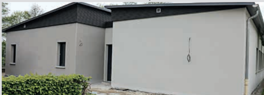
Les travaux de l'Espace de convivialité (285 m 2 ), ont débuté en octobre 2016.
