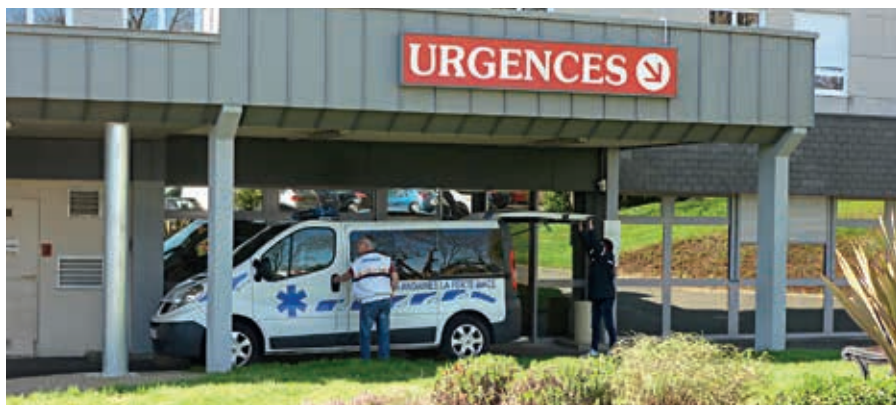
L'entrée des urgences du CHIC des Andaines à La Ferté-Macé a été réaménagée.
