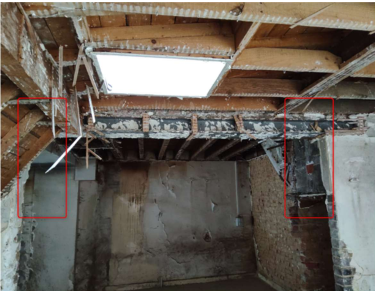
R0 Boulangerie - extension
