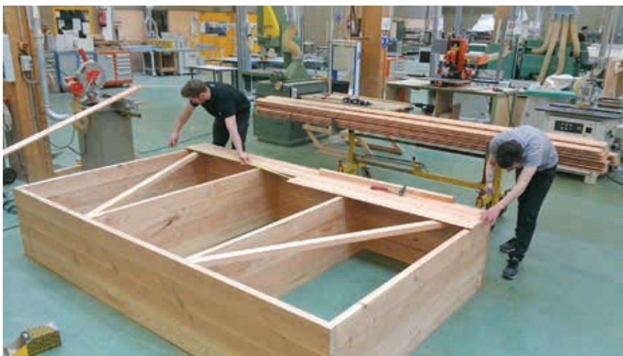
Conception et fabrication de 2 tribunes pour le stade fertois par les BTS 1 & 2 au lycée des Andaines.
