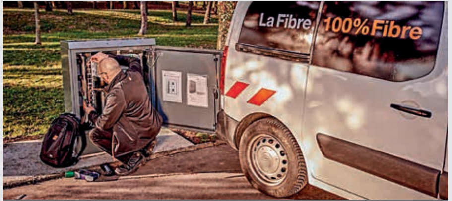
Fin 2019, le déploiement du réseau fibre optique est réalisé dans la rue sur près de 94% de Flers.
