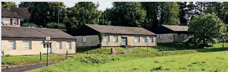
La démolition des bâtiments Charcot est la première étape de l'aménagement du site.
